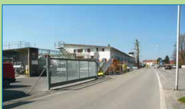
Zufahrt mit Schiebetor
