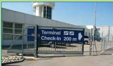
Zufahrt Parkplätze mit Schiebetor
