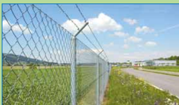
Sicherung mit Diagonalgeflecht
